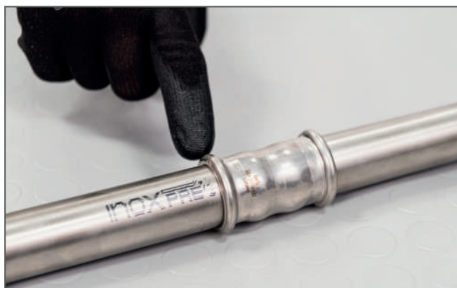
Controllo della pressatura / Checking the press connection
