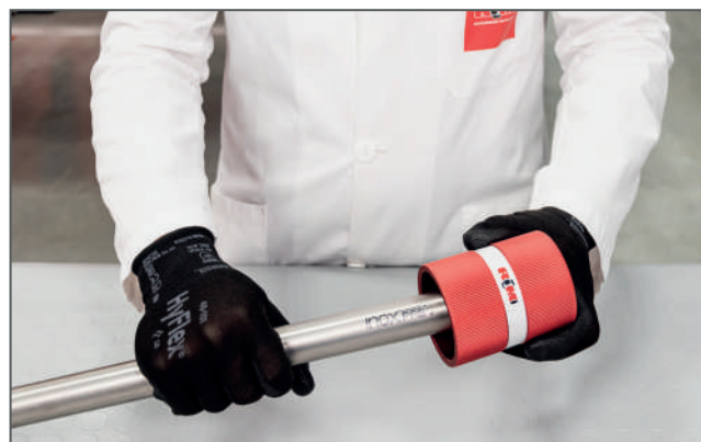
Sbavatura del tubo / Deburring the pipe
