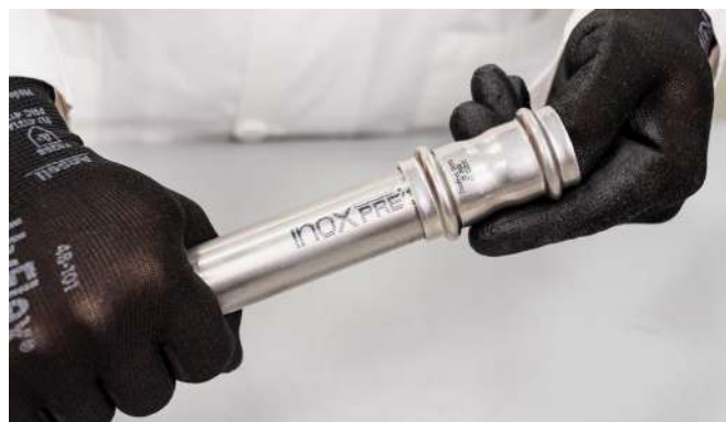
Figura 23 – Inserimento del tubo nel raccordo a pressare
