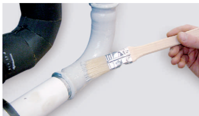
Figura 29 - Verniciatura raccordi e tubazioni con primer
